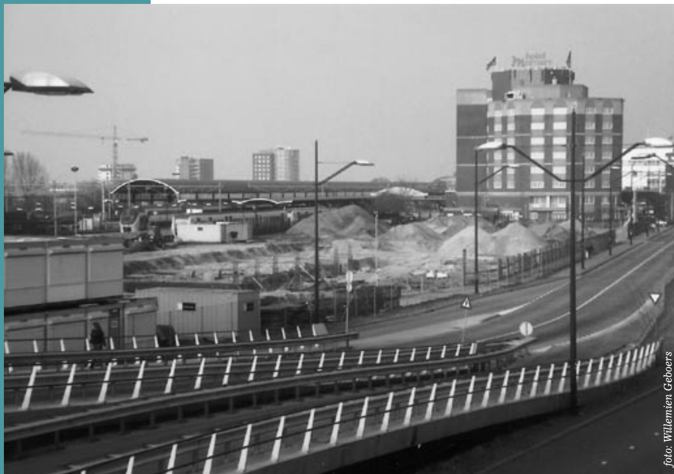
Het toekomstige ROC-gebouw
