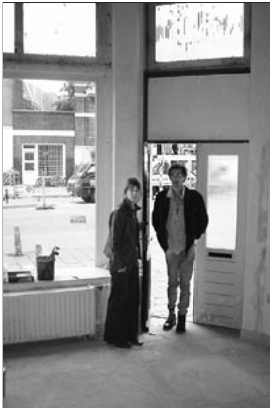
De verbouwing is nog in volle gang.
