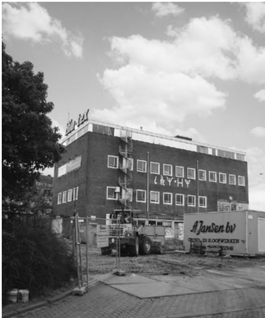
Het Dobbelmanterrein wordt nu bouwrijp gemaakt
