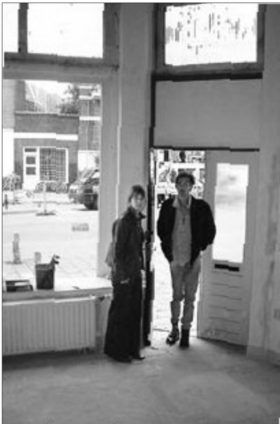
De verbouwing is nog in volle gang.
